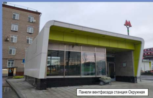
Панели ветфасада станция Окружная
