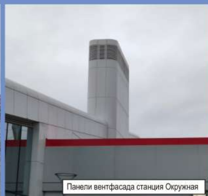
Панели ветфасада станция Окружная
