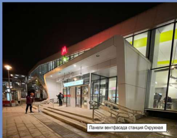
Панели ветфасада станция Окружная
